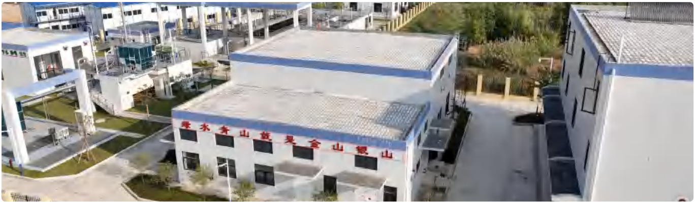
市政污水处理厂区全景 · 涵盖污水收集处理、达标排放与资源化利用全流程
