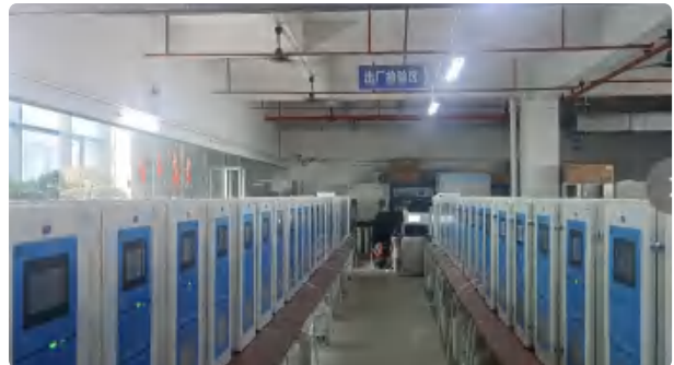
污水处理厂地下廊道巡检作业
