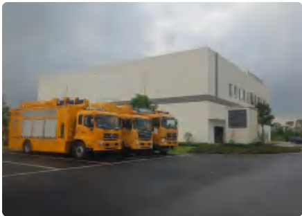
开发区下沉式污水厂污泥处理系统
