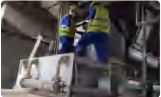
污水处理厂协作应急抢修
