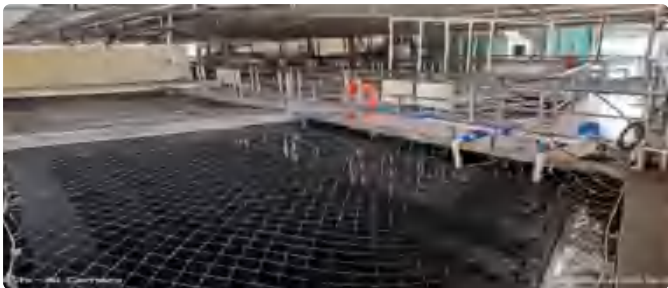
工业园区综合废水处理池体
