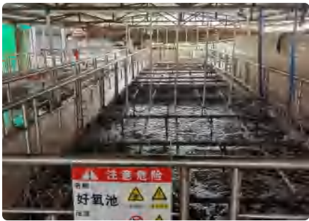
线路板厂废水站技改及运营
