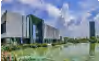
污水处理厂区建筑外观
