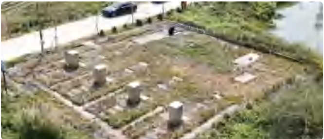
农村生活污水生态处理设施
