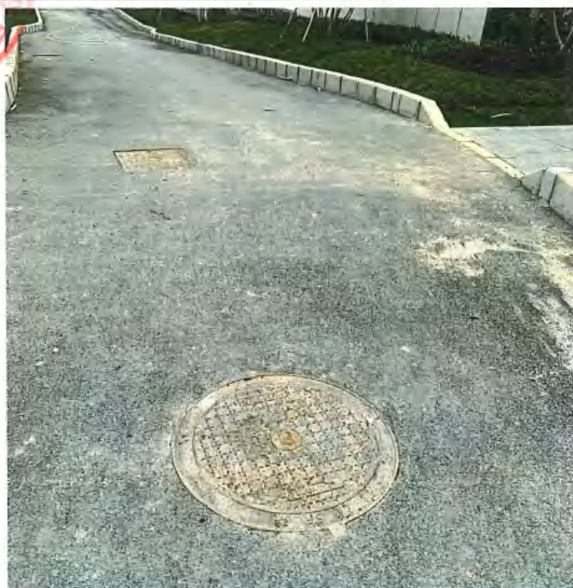
监测范围雨水检查井照片
