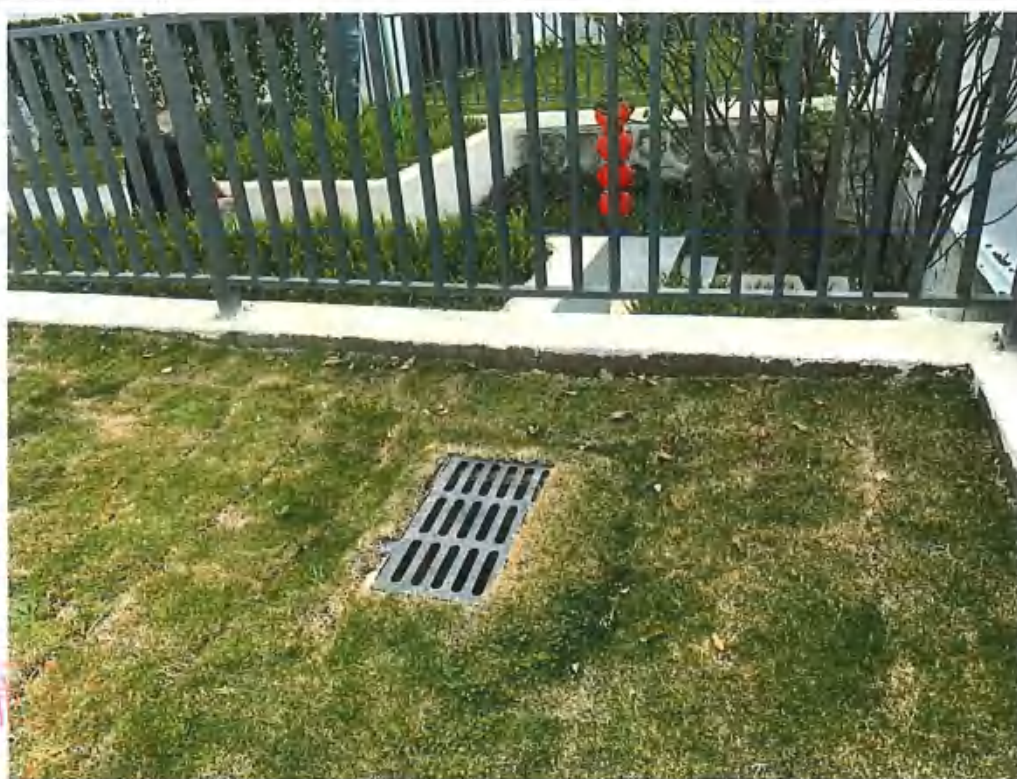
监测范围雨水收集口照片
