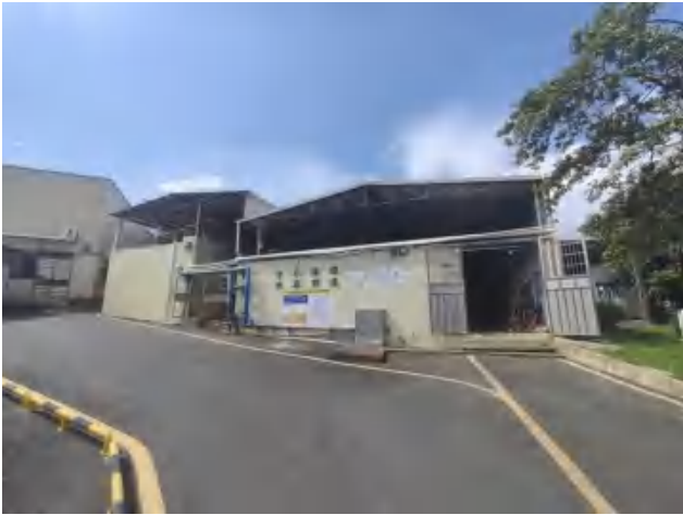
污水处理站（依托原项目）
