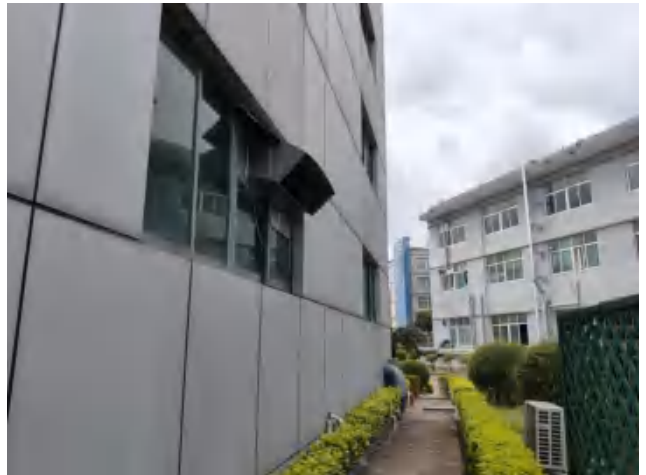
实验车间废气处理后无组织排放口
