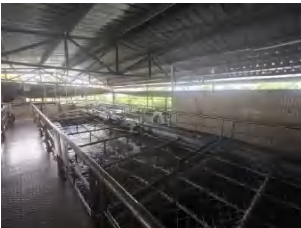
酸化水解+厌氧+接触氧化
