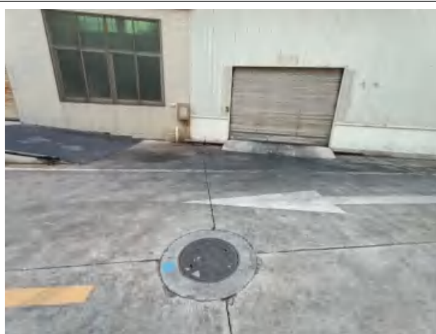
一般固废暂存间（远照） （依托原项目）
