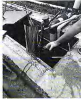
清洗废水处理前采样口
